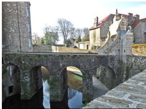
Remarquez ci-dessus un détail signalé par notre guide : à la base du mur, cachée sous l'arche du pont, une poterne permettait aux assiégés de communiquer discrètement avec l'extérieur.
